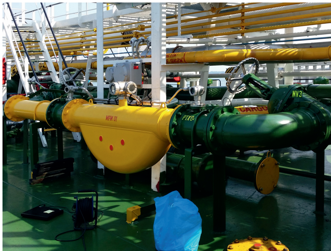
Het compacte bunkermeetsysteem van Endress+Hauser past overal. Hier in een installatie op een binnenvaartschip
